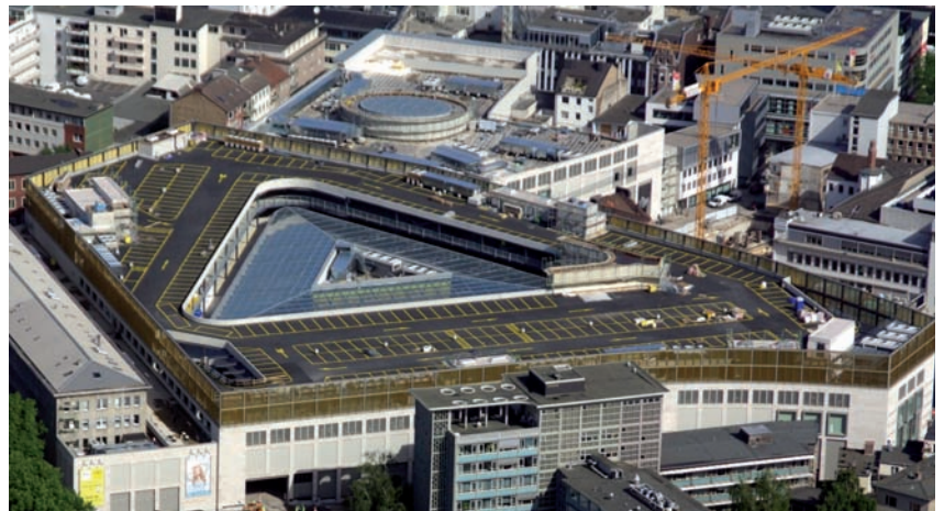
Zentraldach mit Rotunde
