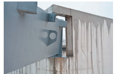
Auflagerung Gratträger Betonkern
