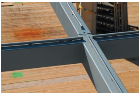
Unsichtbare Rohrverschraubung Hohlprofile
