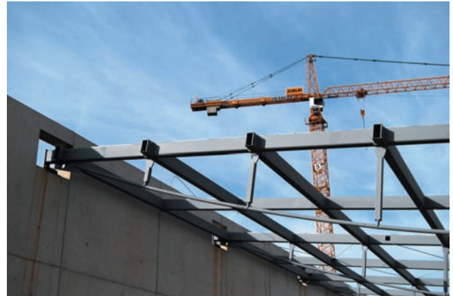
Auflagerung unterspannte Träger
