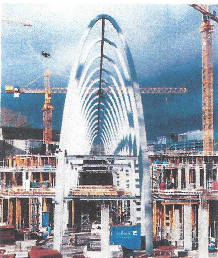
Bild 1. Kathedralenartige Stahlbögen mit Mallbrückenträgern (© Werksfoto Vollack Bautechnik®)
