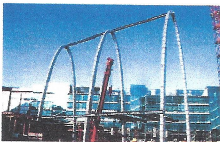
Bild 9. Auflagerbock mit angehängten Bögen (© Werksfoto Vollack Bautechnik®)
