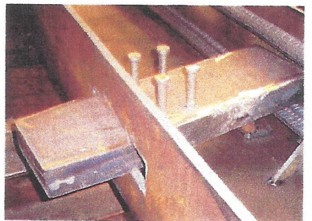
Bild 4. Auflagerbramme zur Kräfteinleitung in den Beton im Brandfall (Warmbemessung) (© Werksfoto Vollack Bautechnik®)
