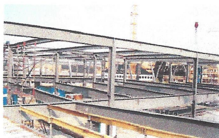
Bild 5. Stahlverbundkonstruktion der Parkebenen (© Werksfoto Vollack Bautechnik®)
