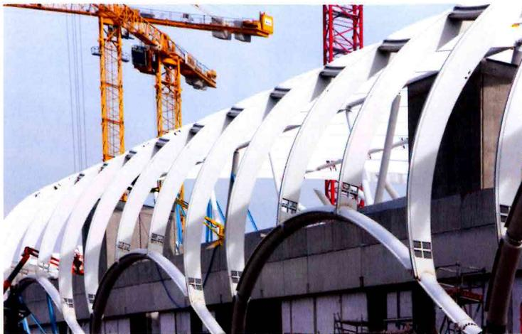
An den Längsrändern werden die Lasten über die Längsbinder aus zweifach gekrümmten Rohren mit einem Außendurchmesser von 506 mm abgetragen
