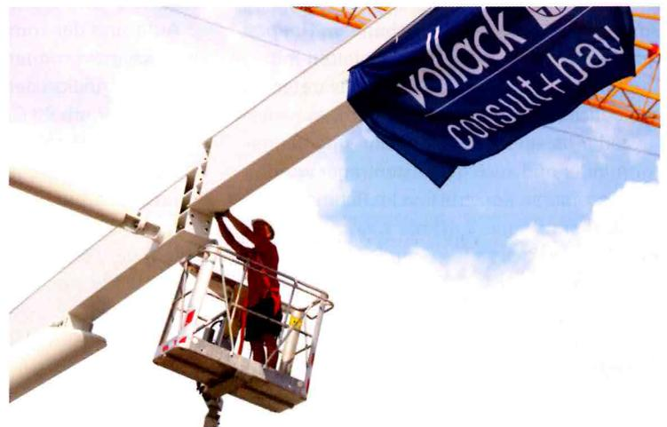
Montage am Schraubstoß eines Kastenträgers, der ebenfalls geschraubte Anschluss an die Rundrohrpfetten ist links zu sehen
