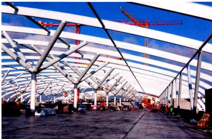
Insgesamt wird die Dachkonstruktion von 32 Baumstützen mit 128 Ästen und 16 V-Stützen mit 32 Ästen getragen
