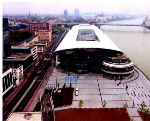
Architektonisches Highlight ist das von einer Stahlkonstruktion gehaltene Membrandach
